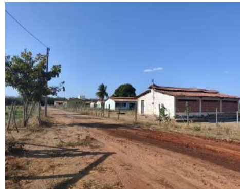
Foto 45: Ausência acessibilidade - UEC
