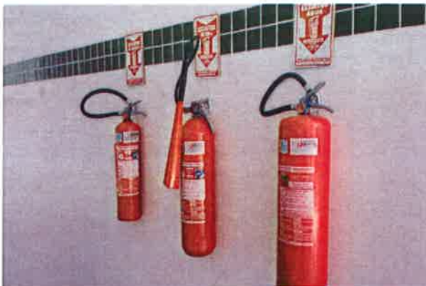
Foto 02: Extintores e incêndio novos
