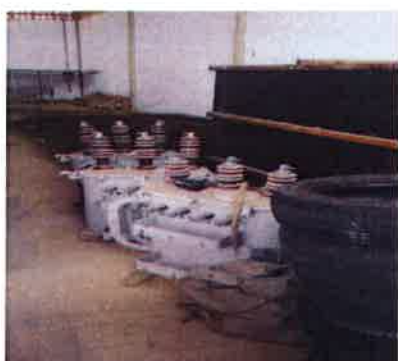
Foto 12: Transformadores antigos trocados
