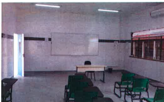
Foto 16: Conservação das salas de aula
