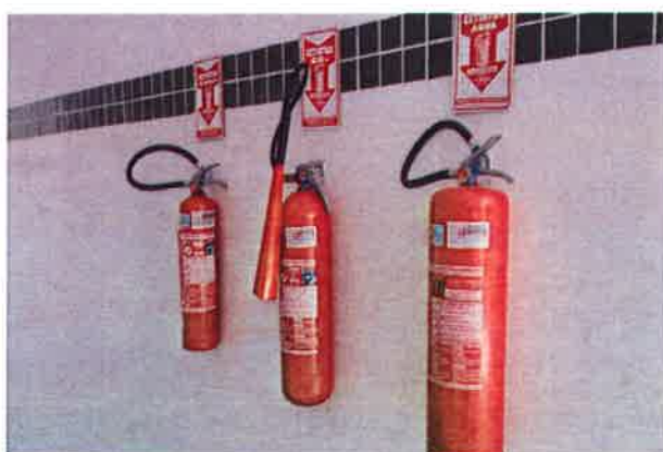
Foto 13: Extintores de incêndio
