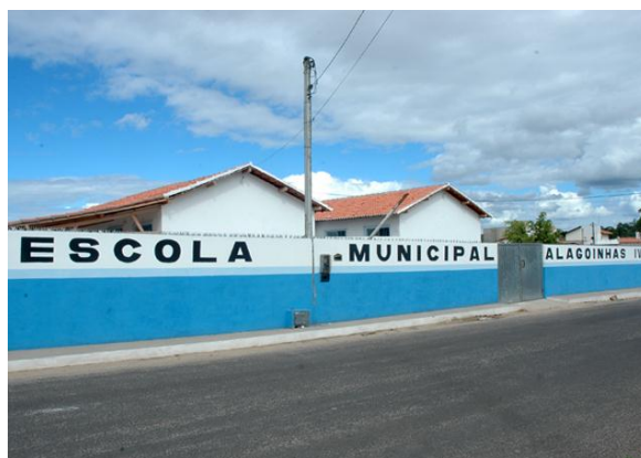
Figura 2: Fachada da Escola Municipal Alagoinhas IV
