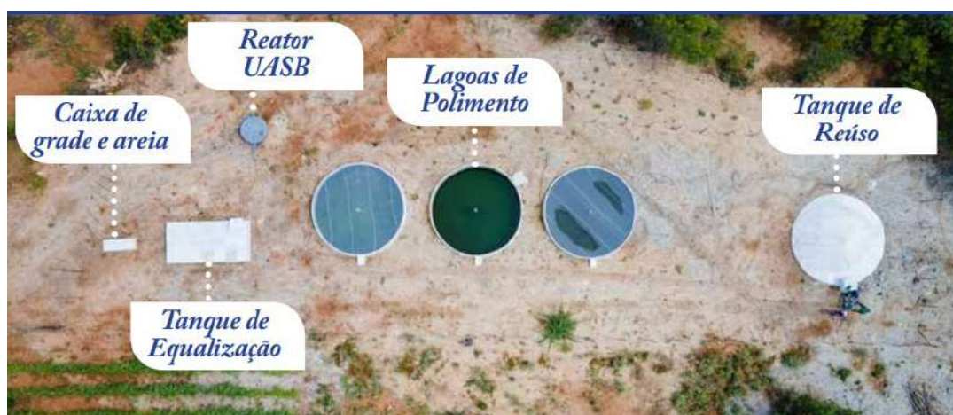
Figura 7 - Visão área do sistema de tratamento das águas residuárias.
