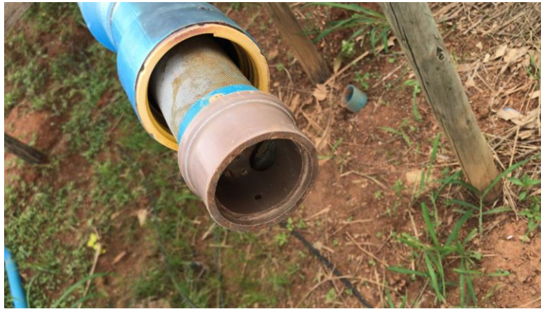
Figura 3. Filtro FAT60 com a representação da estrutura montada. Fonte: próprio autor.
