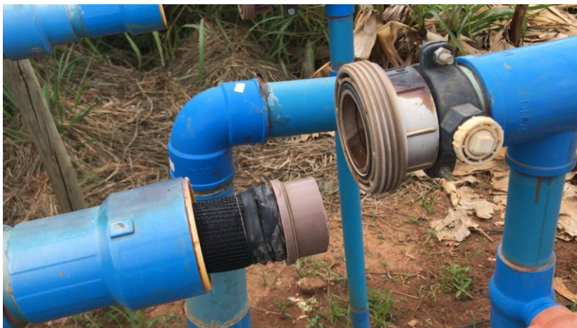
Figura 5. Filtro FAS60 com a representação da estrutura montada. Fonte: próprio autor.
