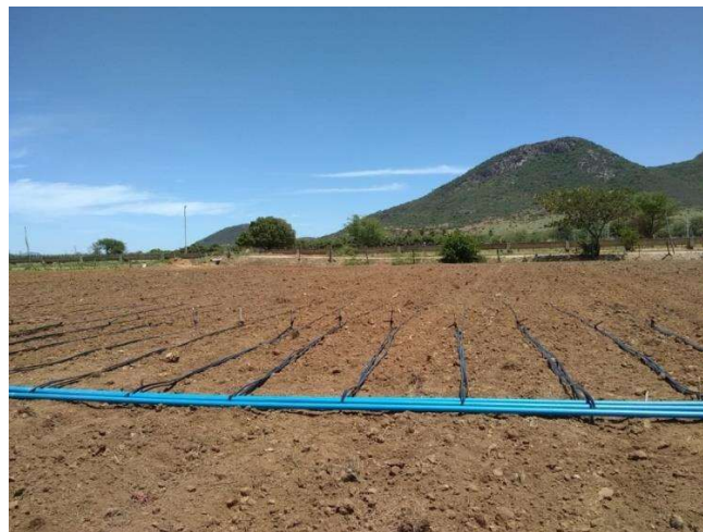
Figura 5. Instalação do sistema de irrigação. Fonte: Autora.
