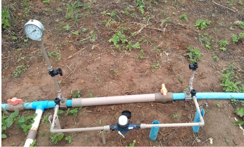
Figura 7: Sistemas de irrigação com um hidrômetro para medir o volume de água e um manômetro para medir a pressão da água no sistema. FONTE: Autor em 23.08.2021.
