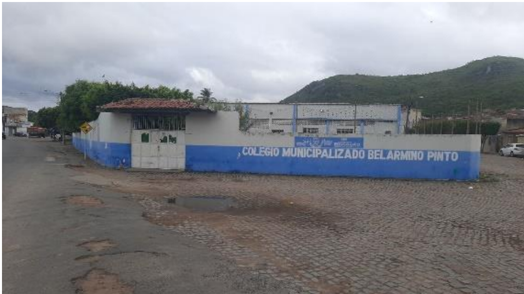
Figura 2: foto da fachada do Colégio Municipalizado Belarmino Pinto em Itiúba-BA. Fonte: Acervo do autor.
