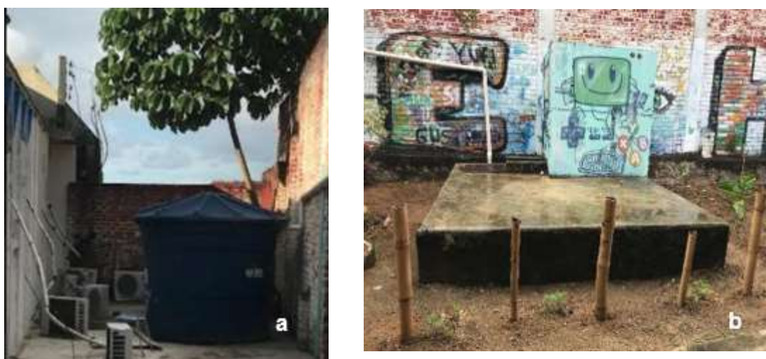
Figura 12. Sistema de captação de água pluvial do CEHMA – reservatório doado (a) e reservatório subterrâneo (b).
