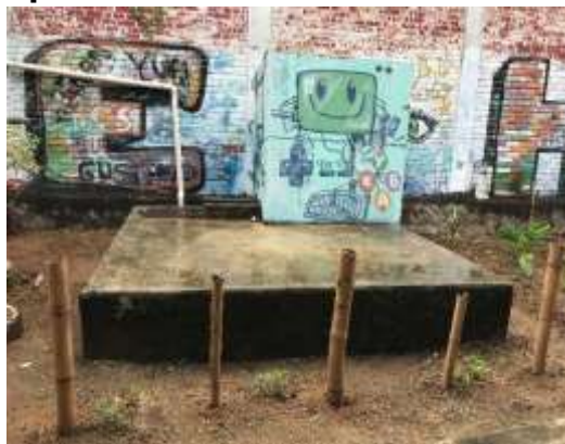
Imagem 19. Sistema de captação de água pluvial do CEHMA – reservatório 2.
