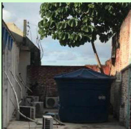
Reservatório de captação de água de chuva
