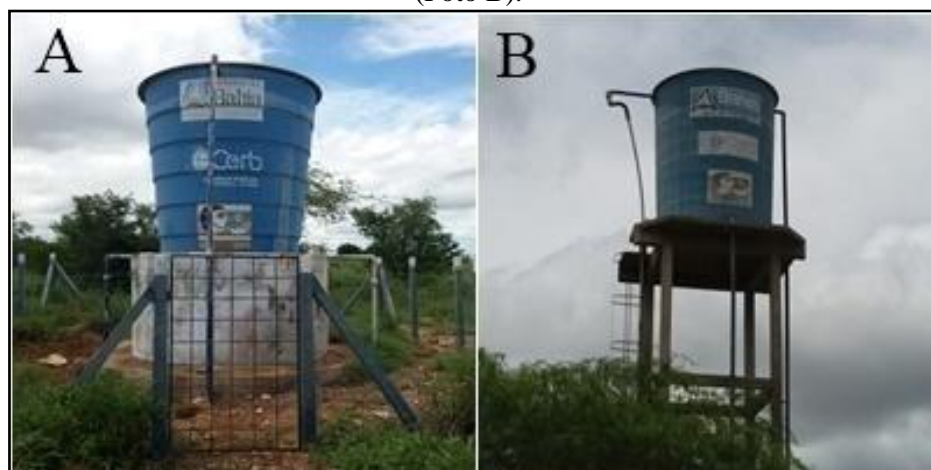
Figura 14 - Fotos das caixas de distribuição de água para Tanque Novo (Foto A) e para Várzea Grande (Foto B).
