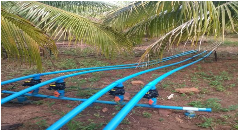
Figura 8. Sistema de válvulas hidráulicas, para o controle das lâminas de irrigação na área de cultivo do coco.
