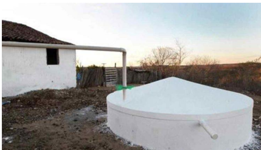
Figura 2. Cisterna de placa
