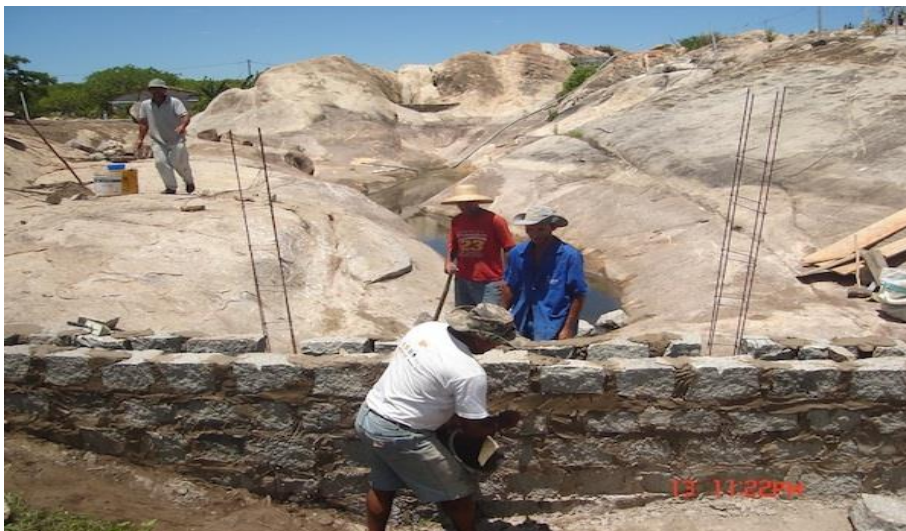
Figura 8. Tanque de pedra
