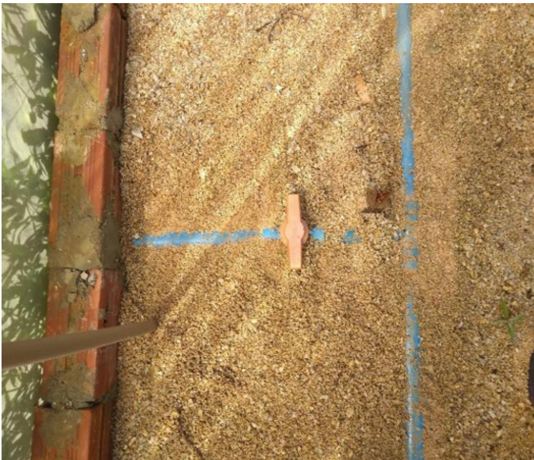
Figura 13 – Detalhe da instalação do sistema de irrigação por gotejamento
