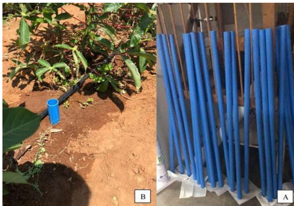
Figura 2- (A) preparo dos tubos de acesso, no laboratório de física do solo; (B) instalação dos tubos de acesso na área experimental do estudo.
